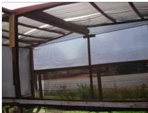
Figura 3 – Vista da estrutura do sombrite.
