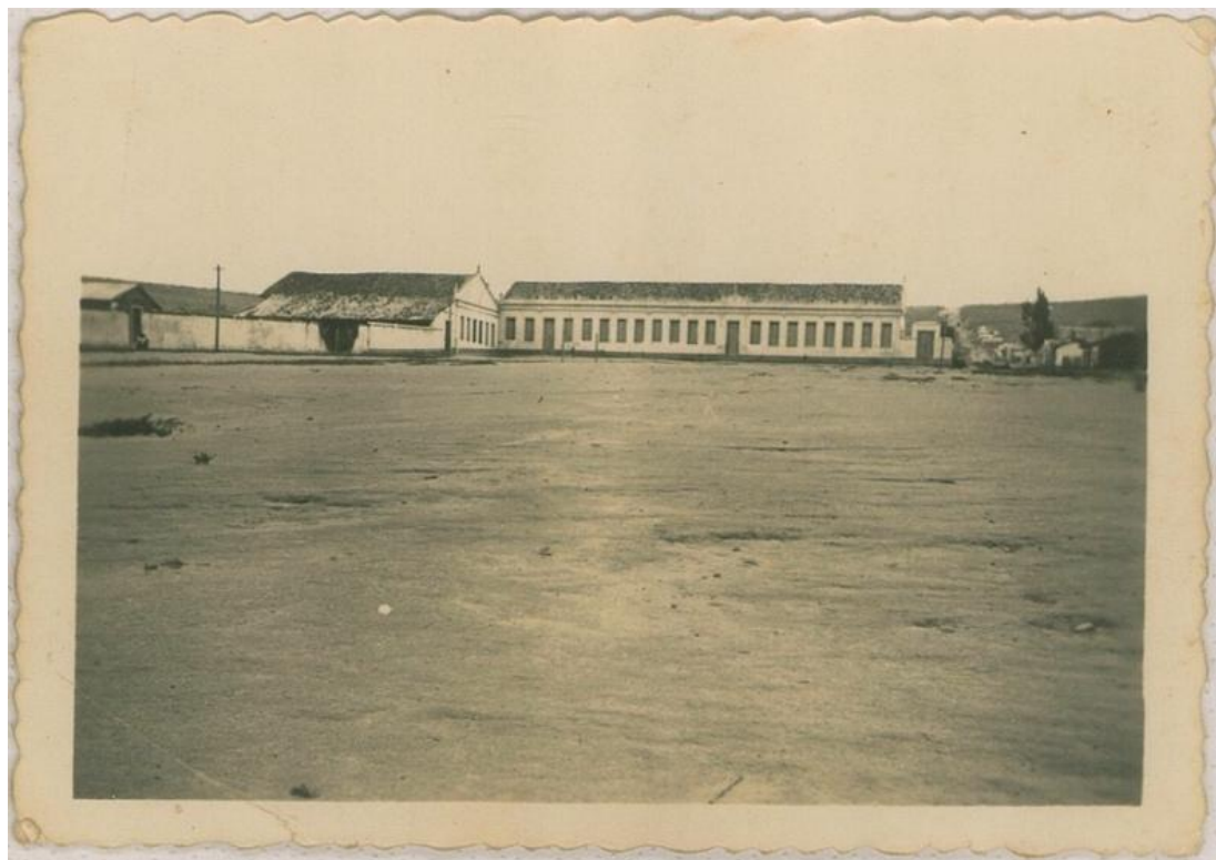
Figura 1 - Foto do prédio de 1940.
