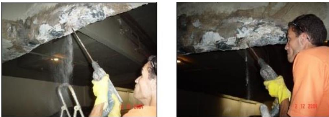
Figura 10 – Perfuração do concreto danificado
