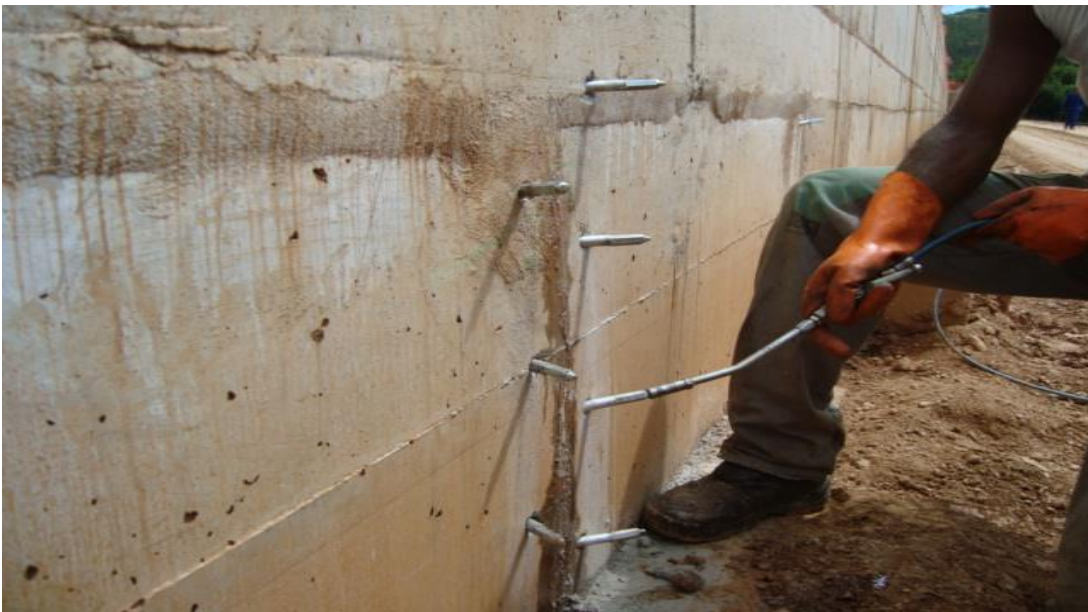
Figura 12 – Tratamento de fissuras
