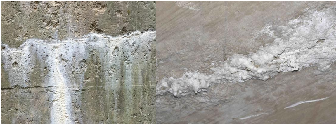
Figura 5 - Carbonatação
