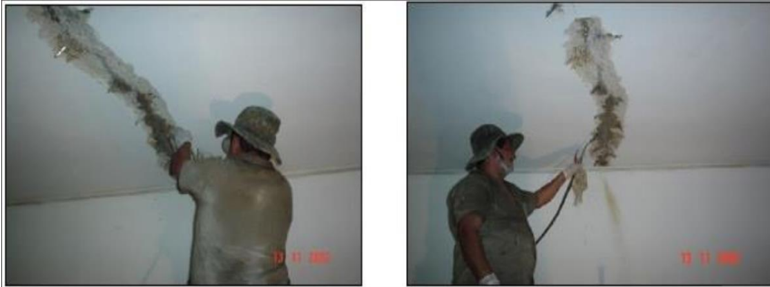
Figura 11 – Aplicação da resina
