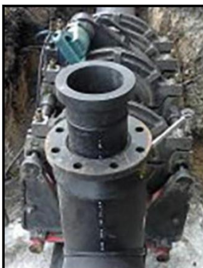
Figura 12 – Conexões por solda
