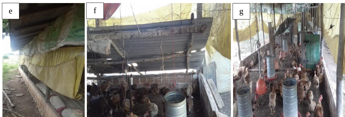
Figura 6: Caracterização dos tipos de materiais e construção do aviário, sendo a) telhas de zinco; b) sacos de tecidos; c) pilares de madeira lado direito; d) pilares de madeira lado esquerdo; e) mureta de tijolo cerâmica; f) telhas de zinco para aquecimento interno e g) vista interna completa
