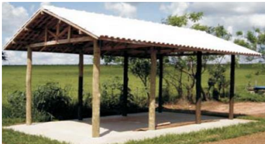
Figura 29: Utilização da pintura reflexiva em uma cobertura
