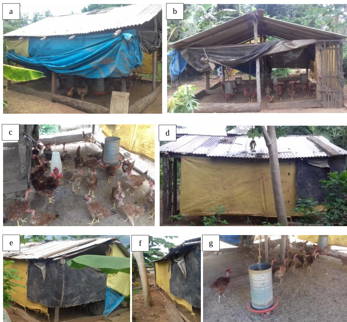
Figura 8: Caracterização dos tipos de materiais e construção do aviário (S), sendo a) lona do tipo plástico de cor preta; b) pilares de madeira de árvores da região; c) vista interna; d) lona plástica de cor amarela; e) vista posterior; f) mureta de madeira parte externa e g) divisão internas por madeira de árvores nativas da região
