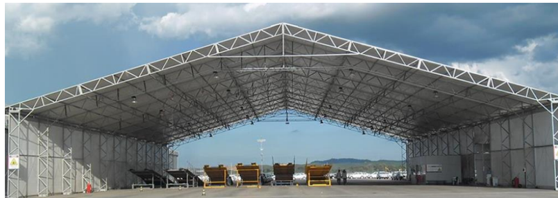
Figura 1: Galpão Treliçado Metálico.
