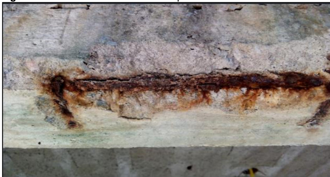
Figura 6 - Fissuras decorrentes do ataque de cloretos
