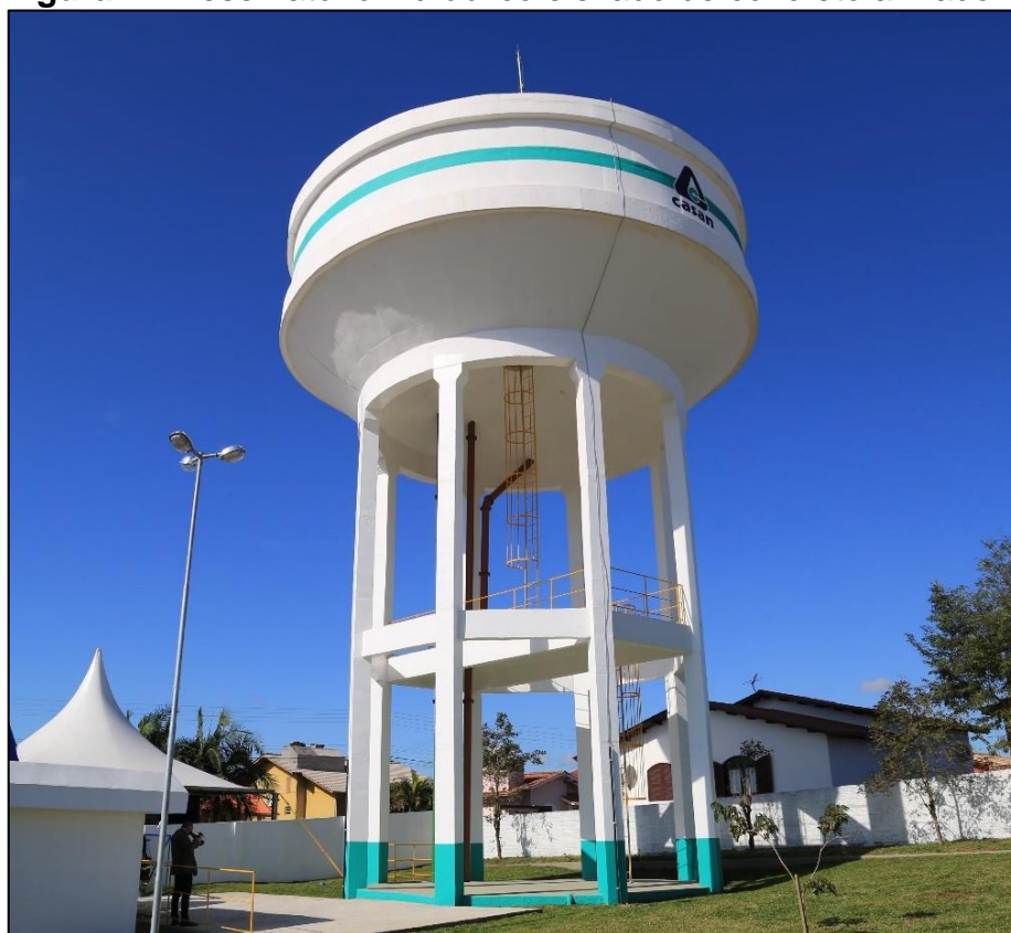
Figura 4 - Reservatório hidráulico elevado de concreto armado
