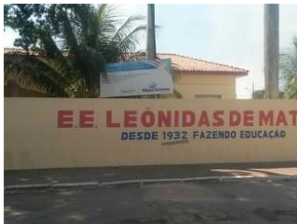
Figura 3: Fachada atual da Escola Leônidas de Matos em Santo Antônio do Leverger
