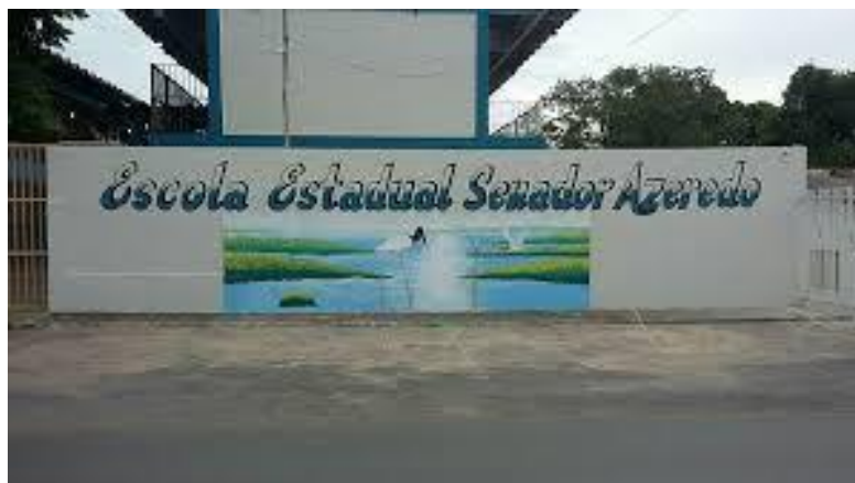
Figura 4: Fachada atual da Escola Estadual Senador Azeredo – Cuiabá/MT
