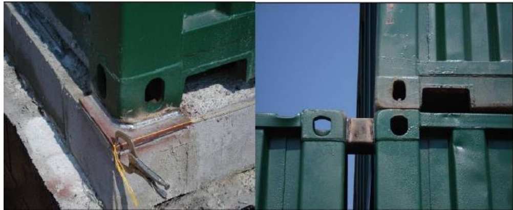
Figura 6 – Ligação da chapa de aço ao container
