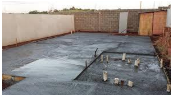
Figura 4 – Fundação radier para container
