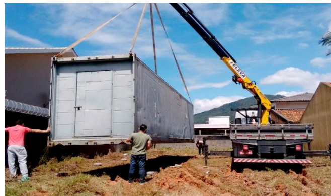
Figura 5 – Caminhão Munck içando o container
