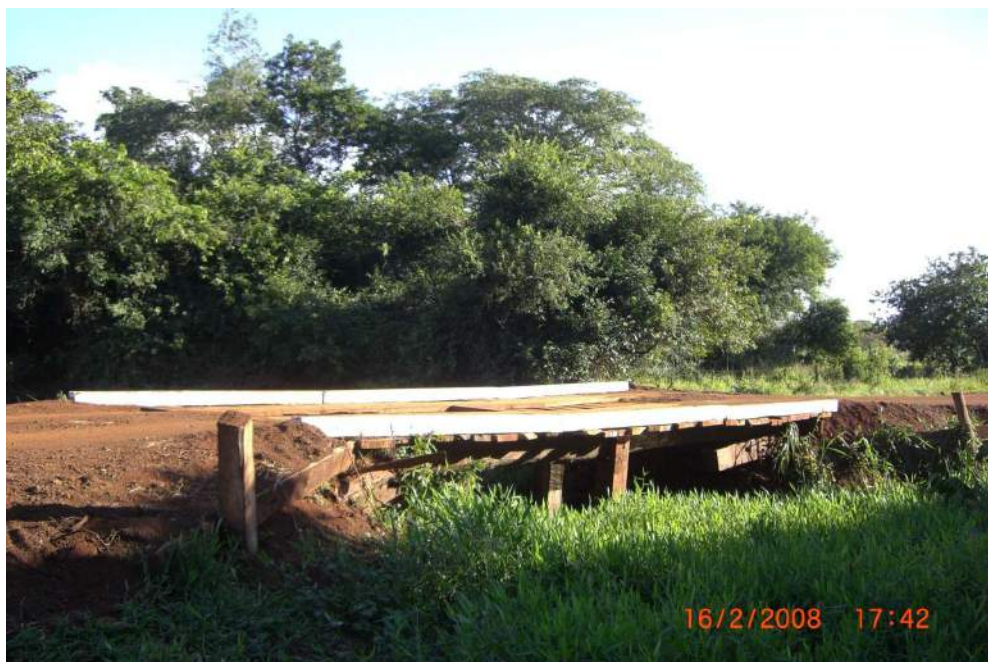
Figura 13 – Ponte construída na década de 1960 em madeira, executada pelo DNR, hoje DNIT, sobre o córrego Araras, próximo a ETE (Estação de Tratamento de Esgoto), em estrada vicinal.
