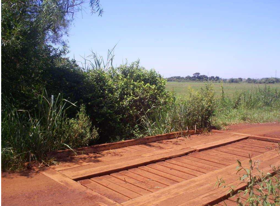
Figura 17 – Ponte em madeira sob o córrego Areias, localizada no Bairro Nova Esperança, executada na década de 1980 pela Prefeitura Municipal. Coordenadas geográficas = Lat: -21°48'55, 653"S" Long: -54°32'36, 835"W" Foto: OLIVEIRA (2008).
