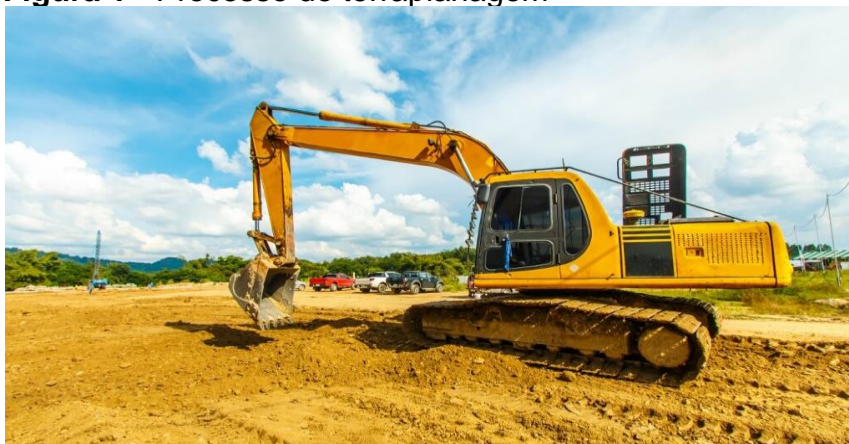
Figura 1 - Processo de terraplanagem
