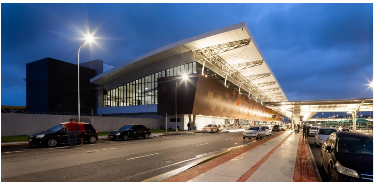
Figura 12 - Vista lateral mostrando o volume da cobertura
