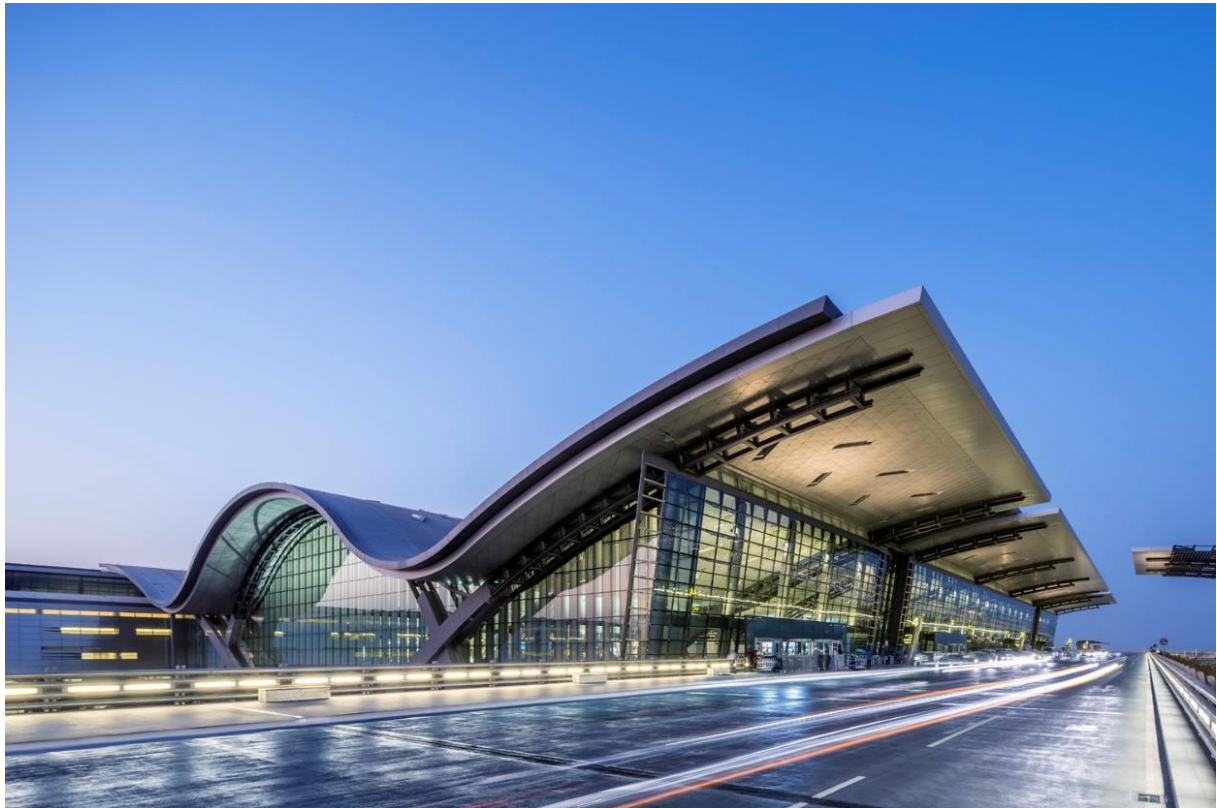
Figura 5 - Uso de metais e vidros na sua estrutura.
