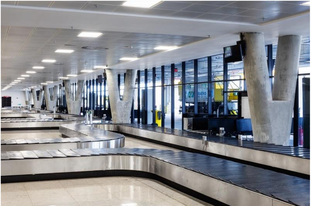
Figura 9 - Sistema de Esteira de Bagagem.
