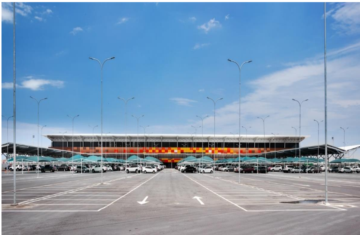
Figura 8 - Foto do Estacionamento.
