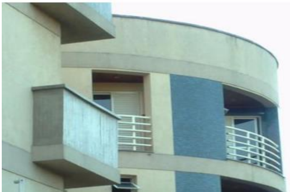
Figura 5- Viga balcão em concreto armado
