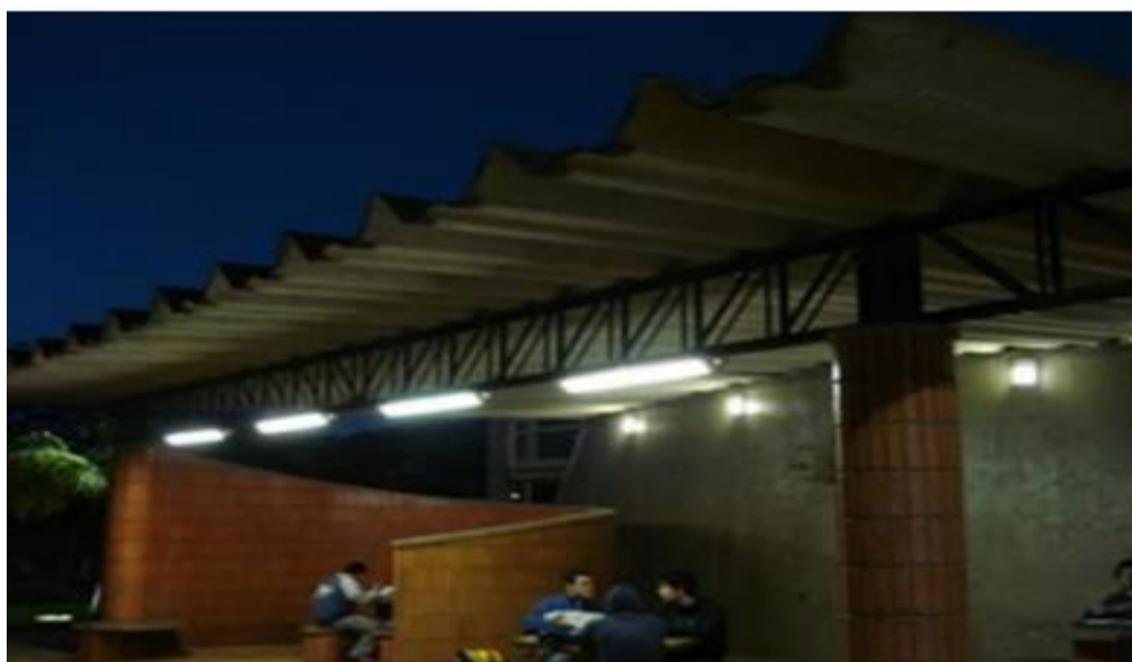
Figura 6- Viga treliçada (ciclo básico)
