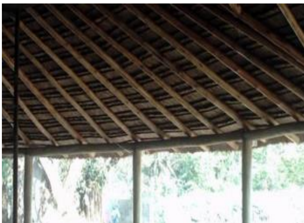
Figura 4- Vigas de madeira com seção circular
