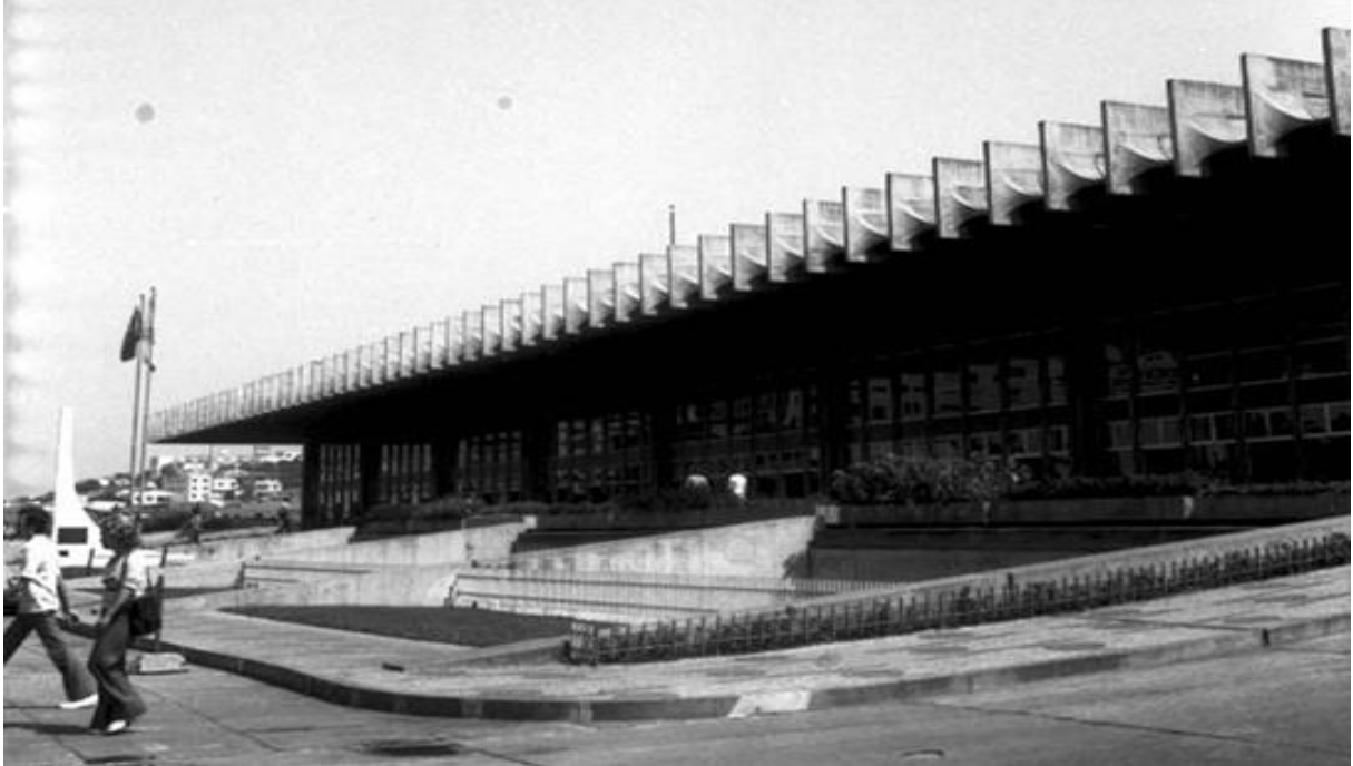
Figura 14 - Terminal Rodoviário Israel Pinheiro no centro de Belo Horizonte em 1941
