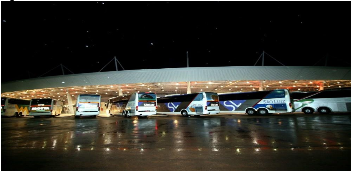
Figura 44 - Terminal Rodoviário – Plataformas
