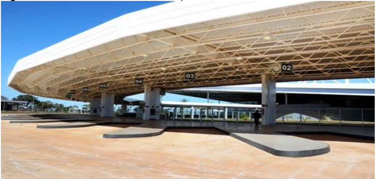
Figura 34 - Rodoviária de Brasília – DF- plataformas
