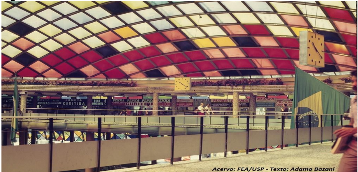
Figura 10 - Terminal Rodoviário da Luz
