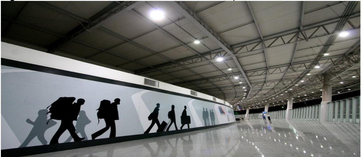
Figura 42 - Terminal Rodoviário – Estrutura metálica e pilares
