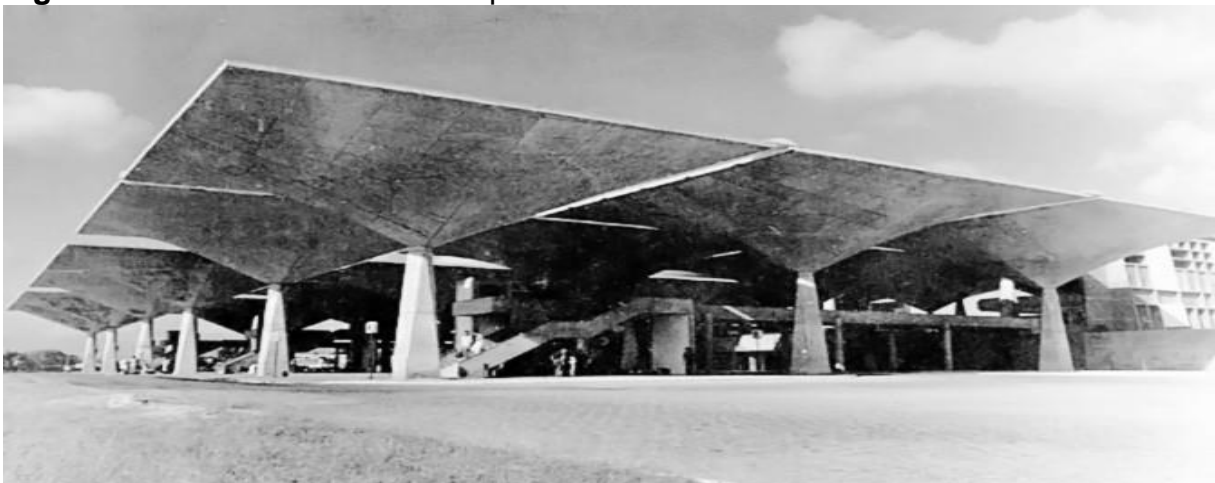
Figura 22 - Módulos estruturais e pilares
