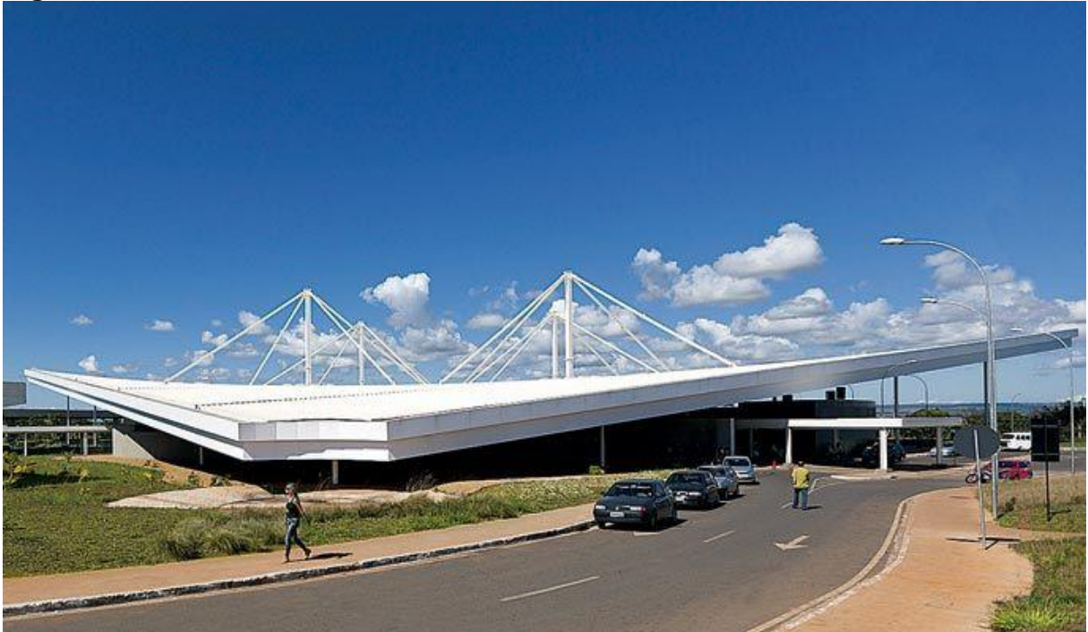
Figura 32 - Rodoviária de Brasília – DF- Telhado
