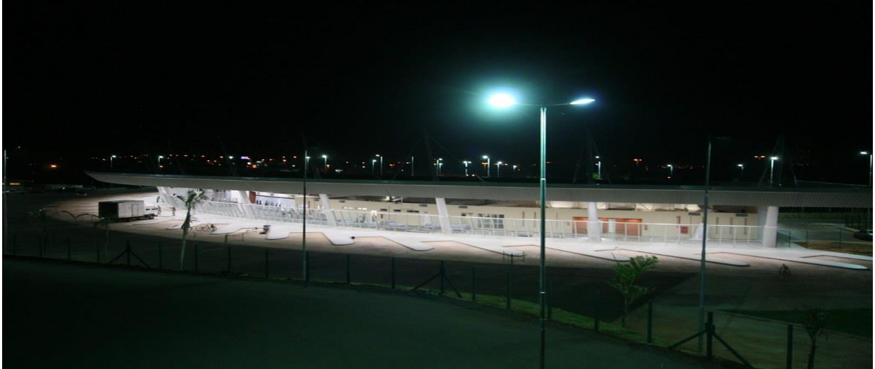
Figura 43 - Terminal Rodoviário – Plataformas
