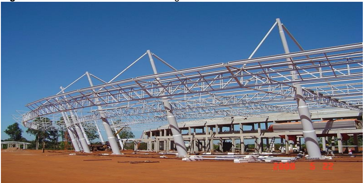
Figura 46 - Terminal Rodoviário – Montagem da Estrutura Metálica
