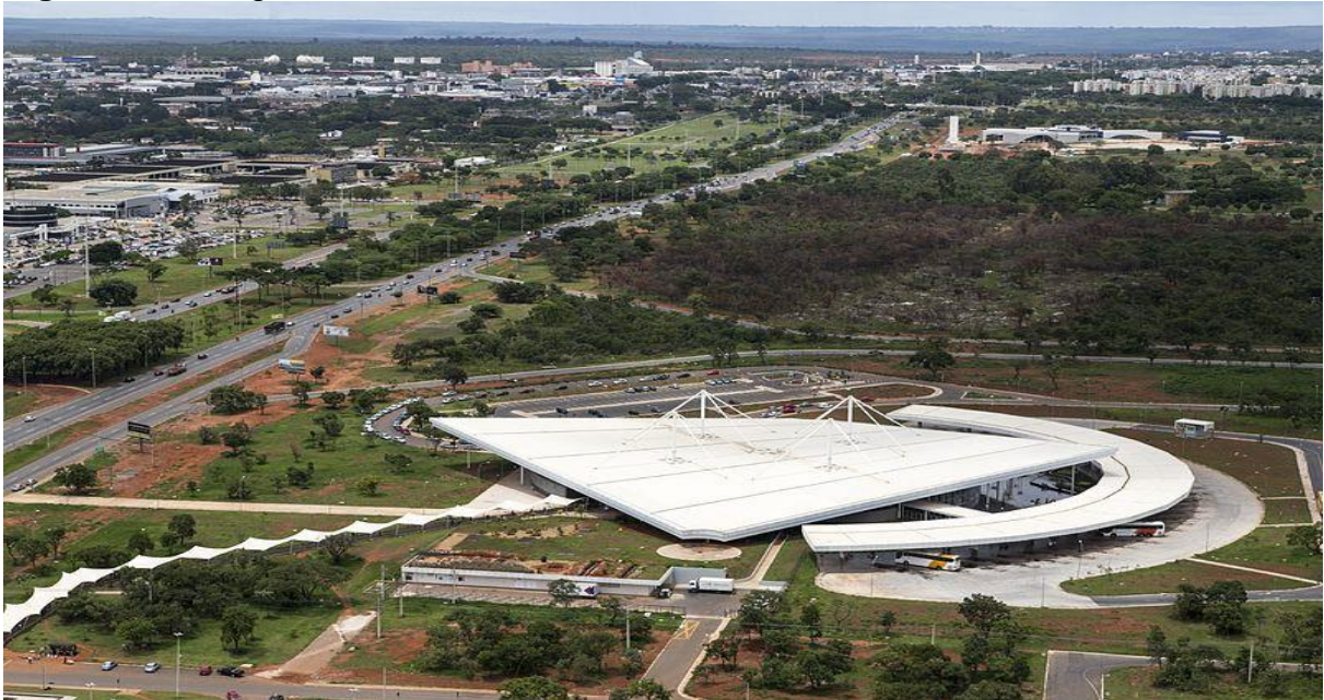
Figura 31 - Imagem aérea da Rodoviária de Brasília - DF
