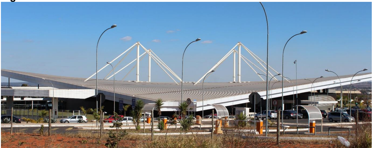
Figura 33 - Rodoviária de Brasília – DF- Telhado
