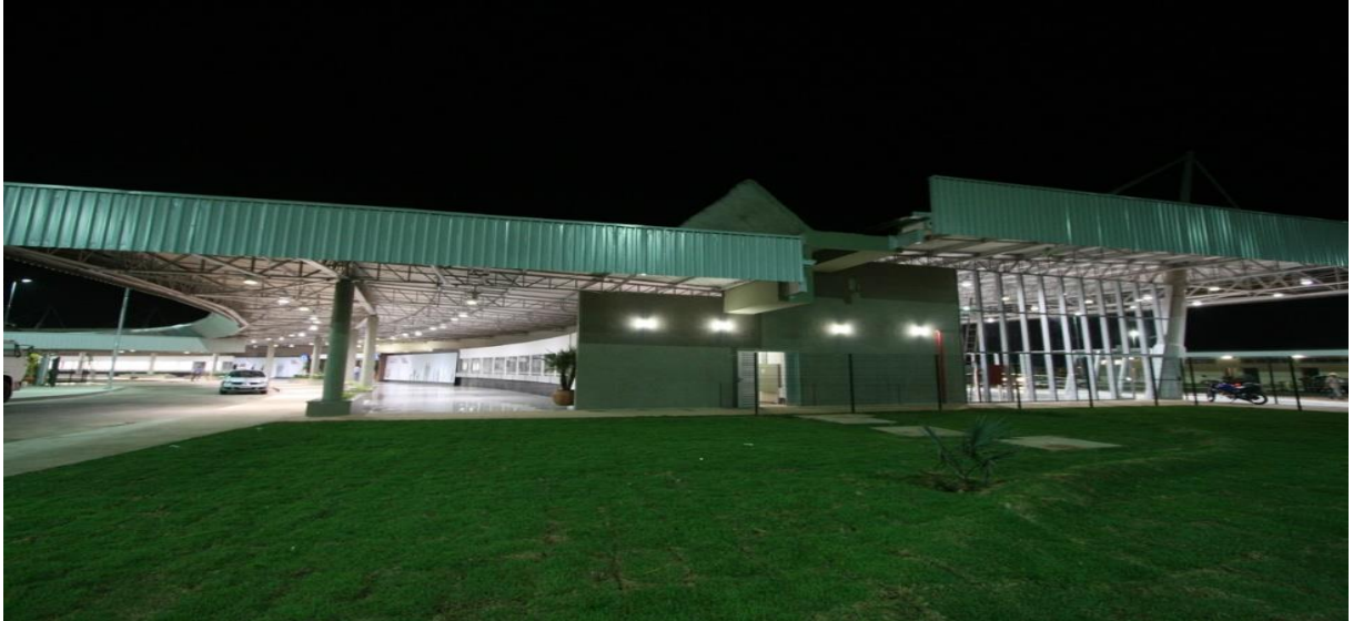
Figura 41 - Terminal Rodoviário – Estrutura metálica
