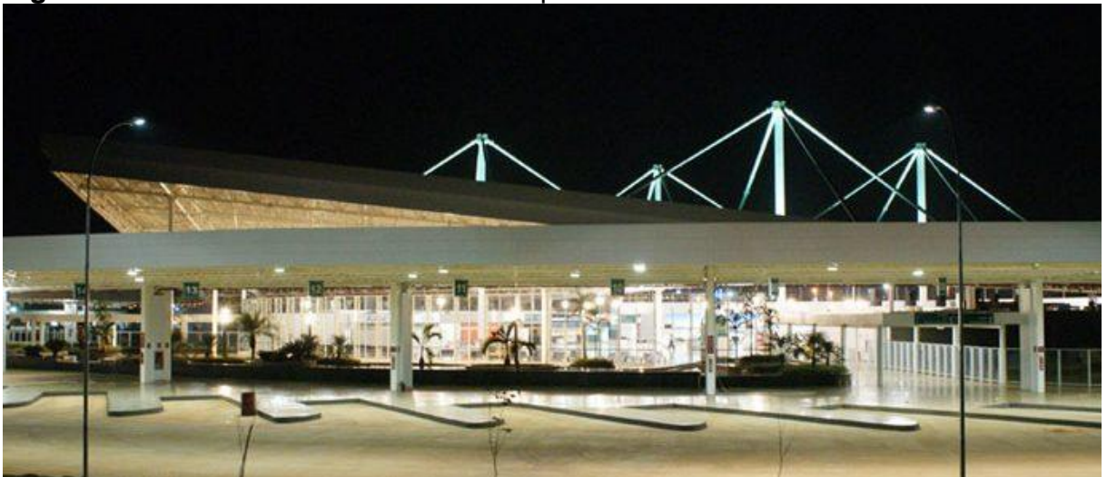
Figura 35 - Rodoviária de Brasília – DF - plataformas
