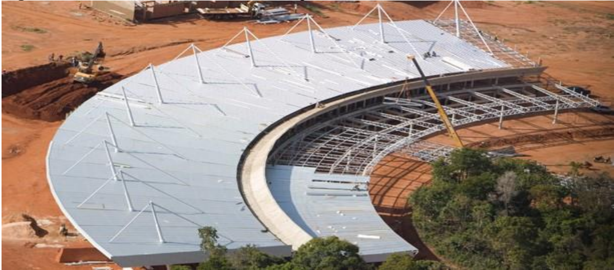
Figura 47 - Terminal Rodoviário – Montagem da Estrutura Metálica
