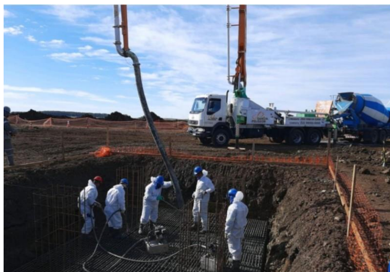
Figura 6 – Fundação para construção de uma subestação
