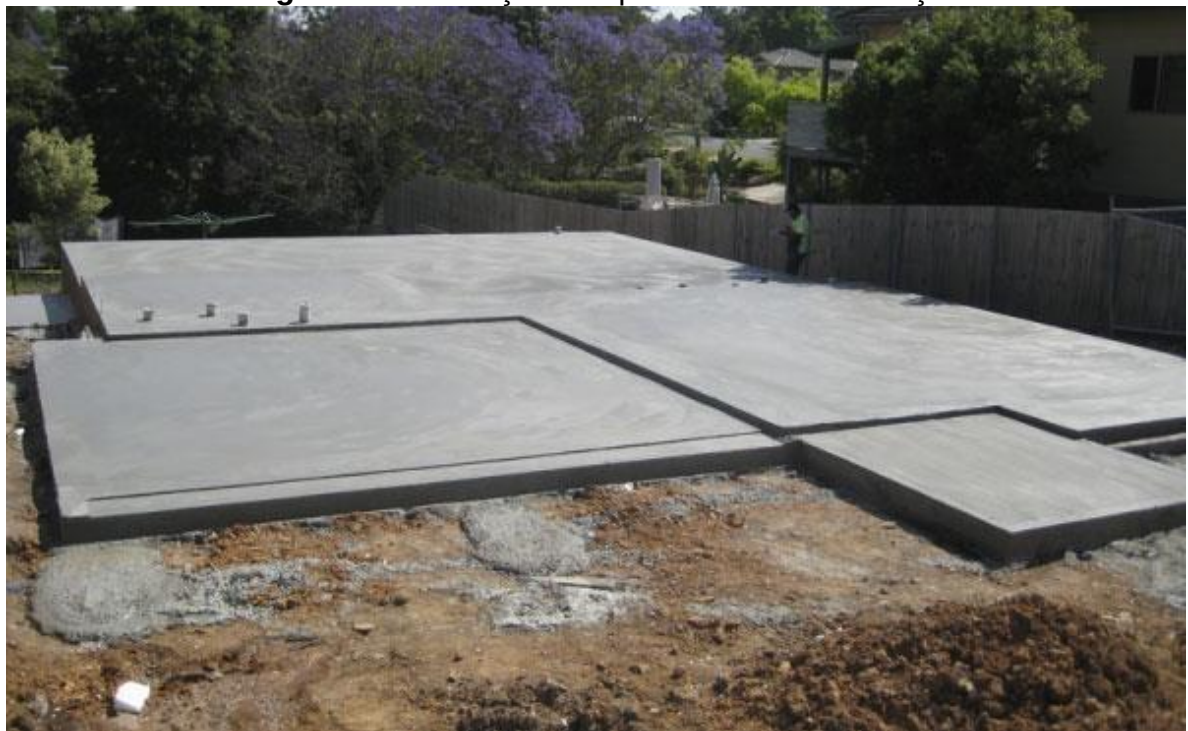
Figura 2 – Fundação do tipo radier em construção LSF.
