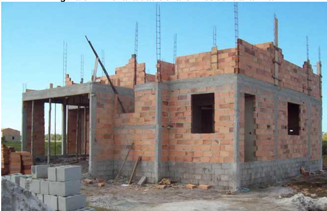
Figura 5 – Alvenaria tradicional em residência familiar.
