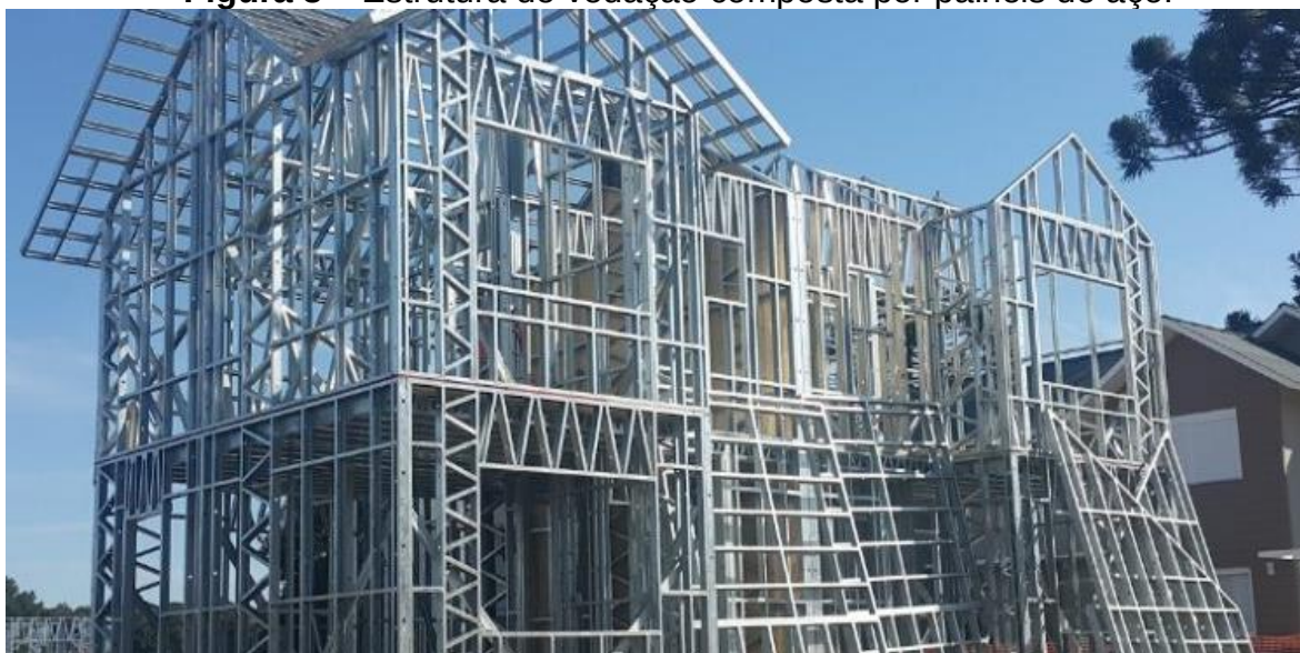
Figura 3 – Estrutura de vedação composta por painéis de aço.
