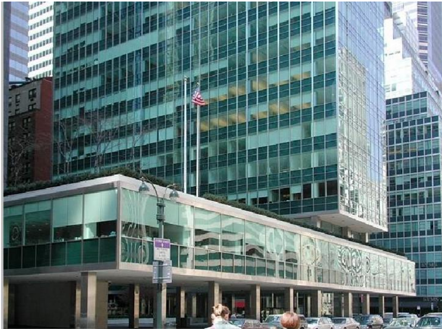
Figura 1: Edifício Lever House (1951-52) em Nova Iorque, projeto do escritório Skidmore, Owings and Merrill .
