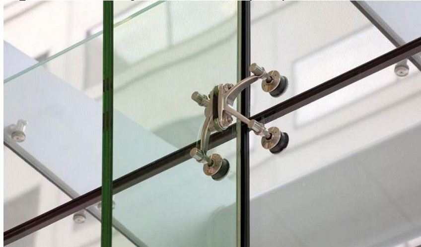
Figura 3: Articulação da fachada tipo Spider .
