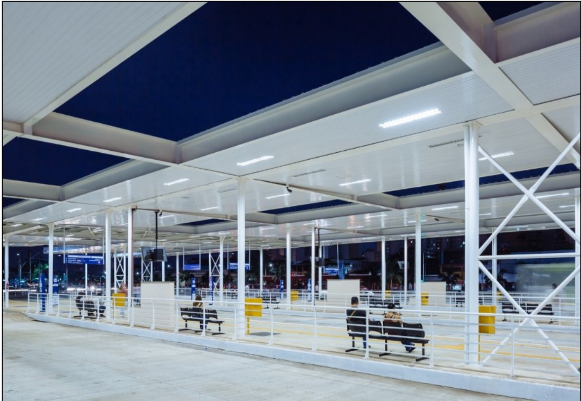
Figura 24 - Cobertura translúcida na passagem de pedestres
