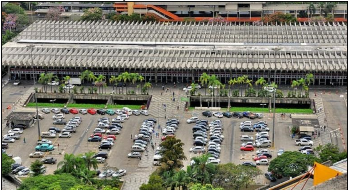
Figura 9 – Vista da cobertura
