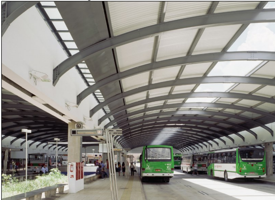
Figura 15 - Detalhe da estrutura
