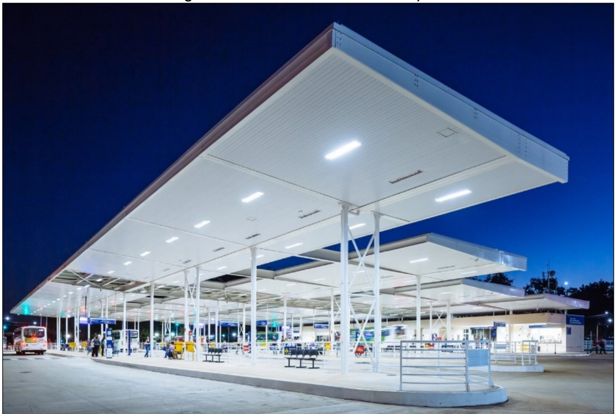
Figura 23 - Estrutura metálica simples
