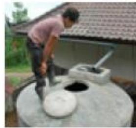
**Tanque séptico de ferrocimento pré-moldado**
