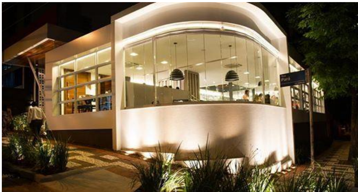
Figura 2 - Fachada ainda sem o uso da parede de cobogó
