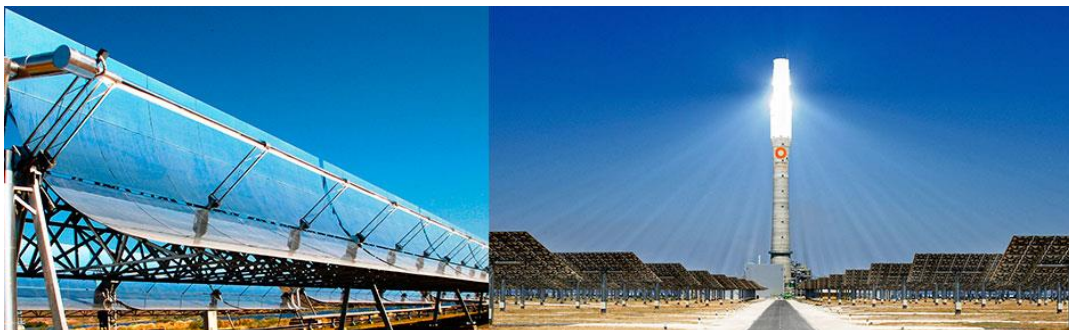
Figura 7- Sistemas CSP: Calha Parabólica (Esquerda), Torre de Energia (Direita)
