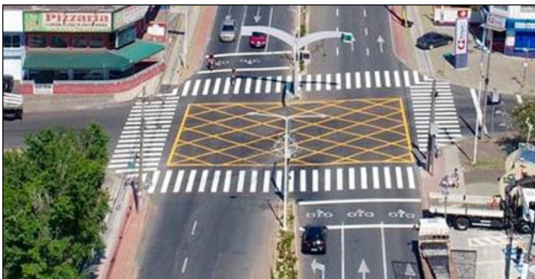
Figura 16. Marcação de Área de Conflito.
