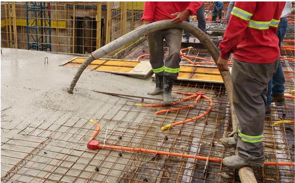
Figura 6 – Concretagem de laje e paredes com concreto auto adensável
