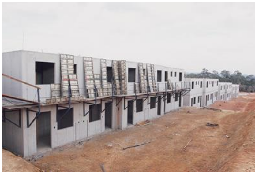
Figura 14 – Canteiro de Obras Parede de Concreto
