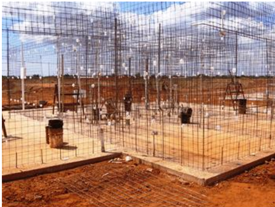
Figura 3 – Telas de Armação para paredes de concreto
