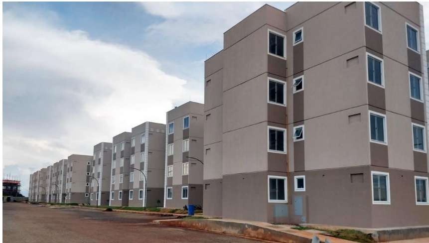
Figura 15 – Residencial Construído em Paredes de Concreto
