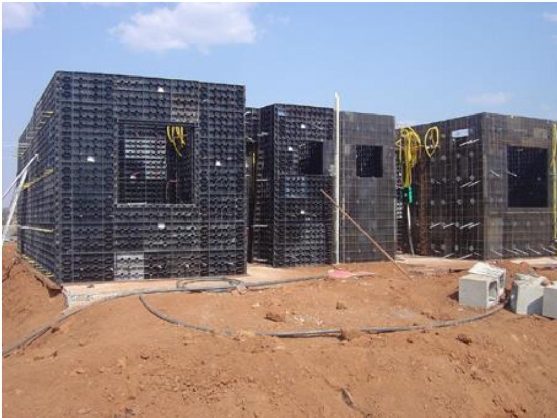
Figura 9 – Fôrmas plásticas para moldagem de paredes de concreto
