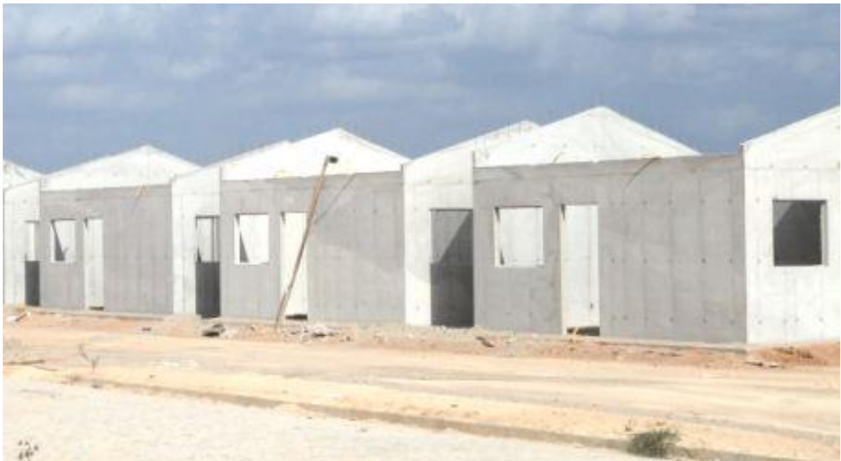
Figura 1 – Casas populares construídas com paredes de concreto moldadas in loco
