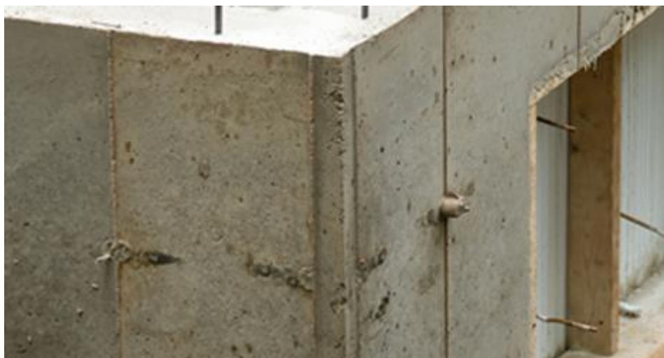
Figura 16 – Parede de Concreto após desforma
