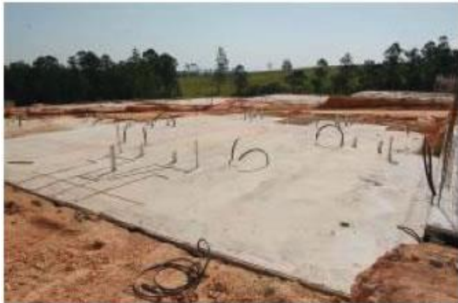
Figura 2 – Radier executado para estrutura de parede de concreto
