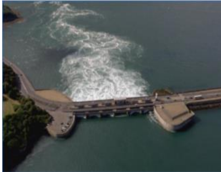
Figura 06 - Usina de La Rance
