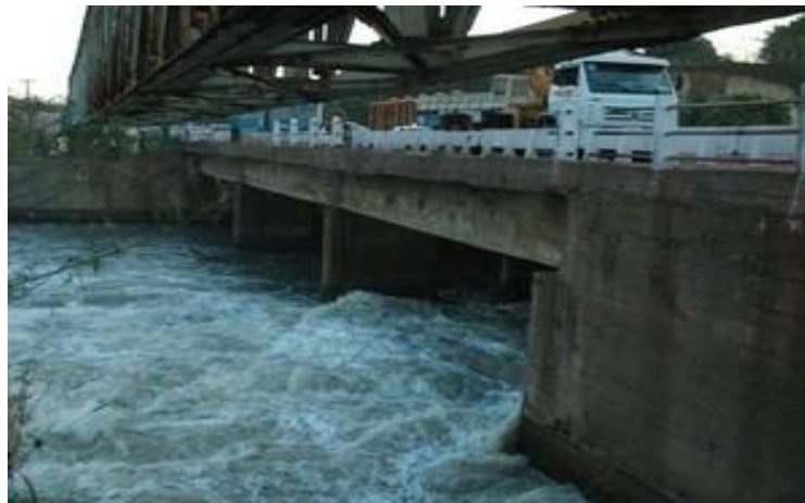
Figura 07 - Barragem de Bacanga
